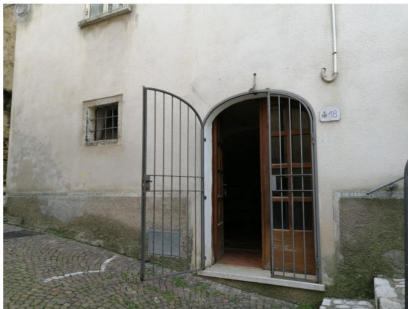
VISTA INGRESSO LOCALE
